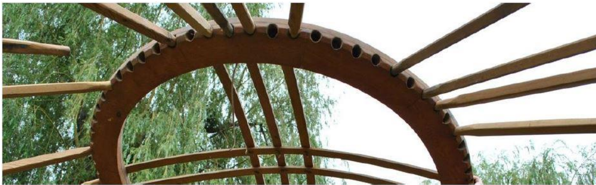
9. ábra A tündök csapfészkeinek és a dorongok csatlakozása (forrás: VASIHELYTORTENET 2016)
