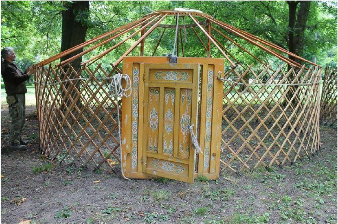
1. ábra A jurta vázszerkezete állítás közben
