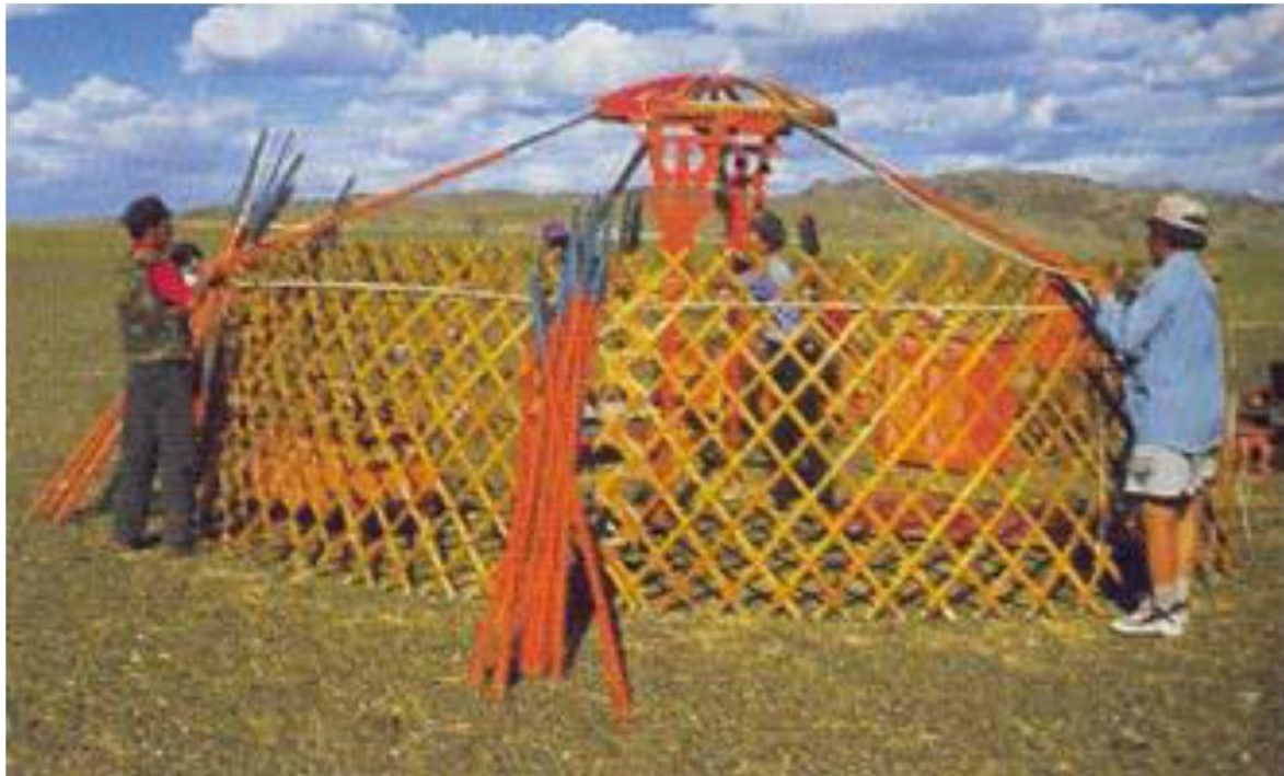
12. ábra A tündök kötelekkel, illetve dorongokkal való pozícionálása (forrás: ETNOCENTER 2016)
