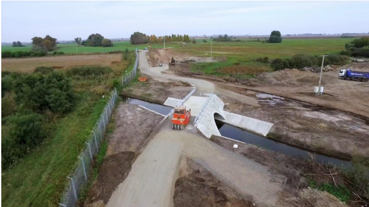
2. ábra. Manőverút egy szakasza építés közben
