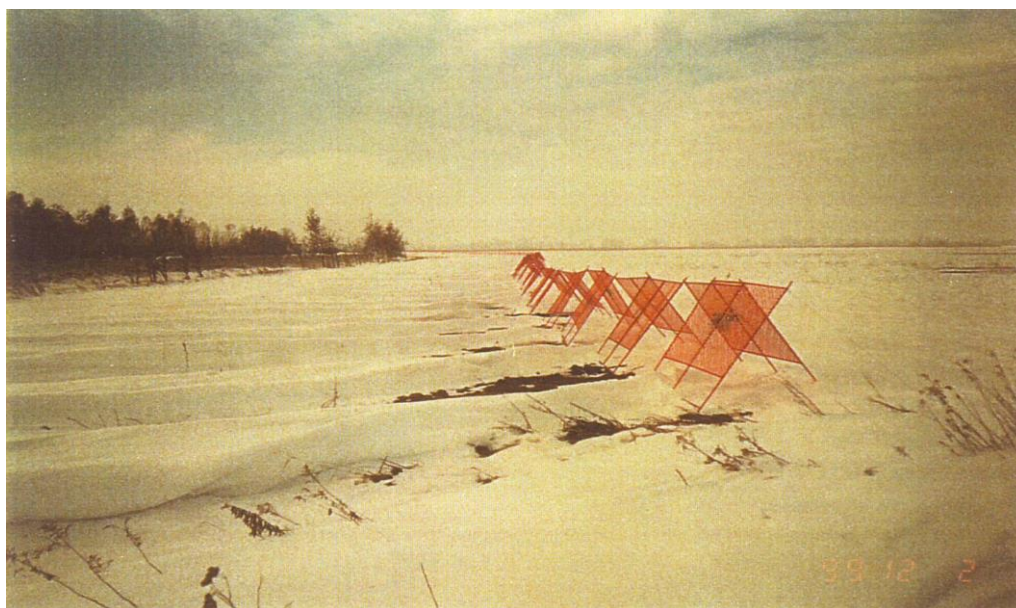
40. ábra Hófogó rácsok alkalmazása (Fotó: Frank N.)
