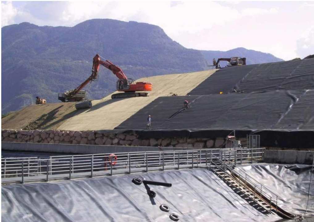
70. ábra Hulladéklerakó szigetelése
