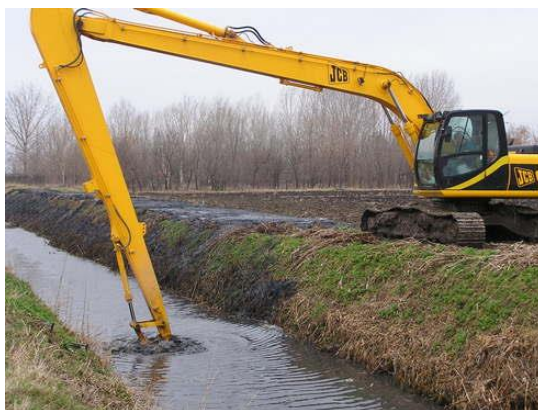
26. ábra: Vízelvezető árkok létesítése a belvizes területeken [12]
