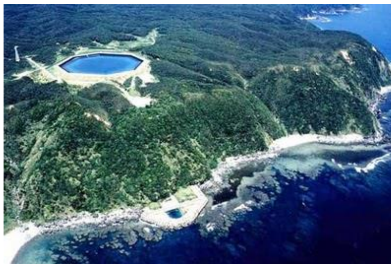
54. ábra: Szivattyús-tározós erőmű Japánban [10]
