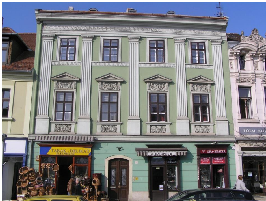
3. ábra. A Várkerület 88. számú épület utcai homlokzata 2011-ben (forrás: szerző)
