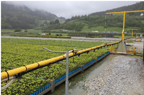
6. ábra. Kalwang-i csemetekert automata öntöző rendszere (fotó: Major T.)
