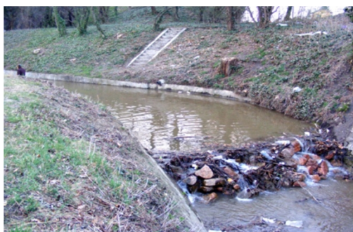
2. ábra: Iszapfogó kőgát a vizsgált szakaszon
